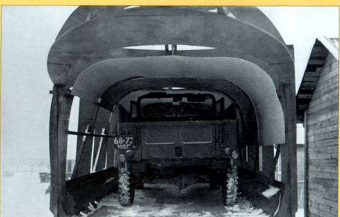
Варианты загрузки вертолета опробовались на макете
