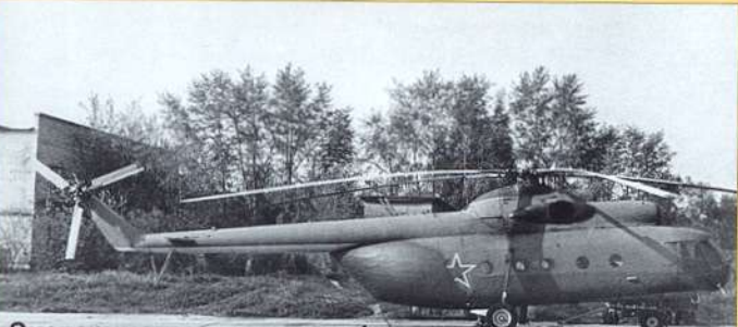
Экспериментальная модификация Ми-8Т с уменьшенным аэродинамическим сопротивлением
