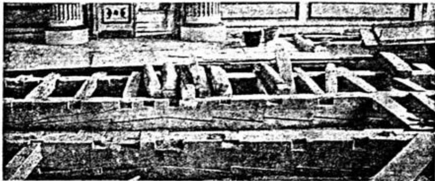
2. Конструкция для укладки паркетного щита. Дворец Останкино
