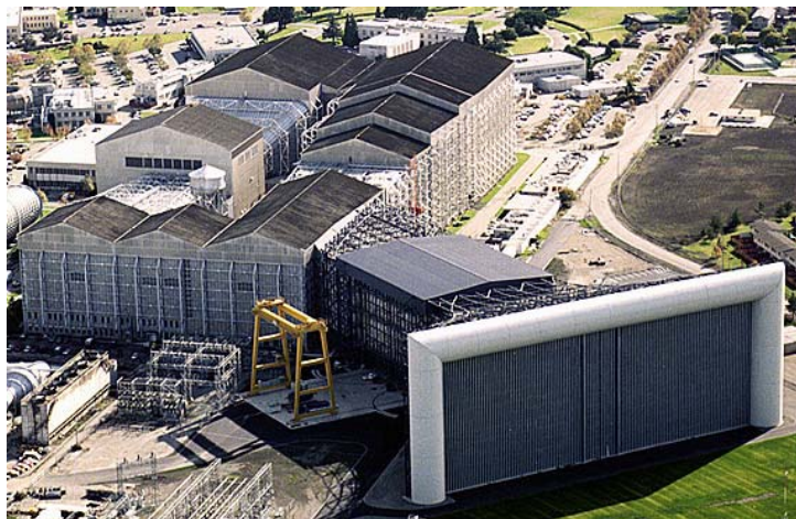
Abb. 2-1: NASA Ames 80 x 120 ft Niedergeschwindigkeitswindkanal
