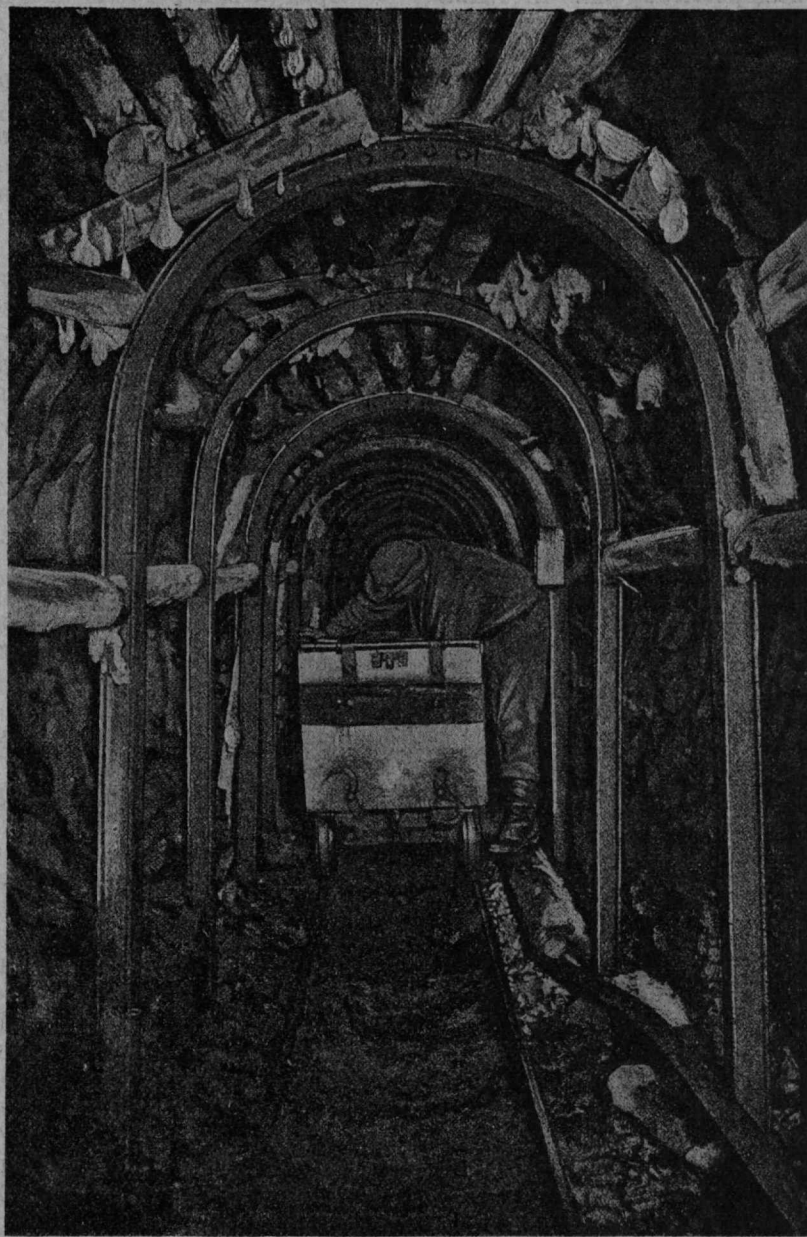
Откаточный штрек, закрепленный железом.
