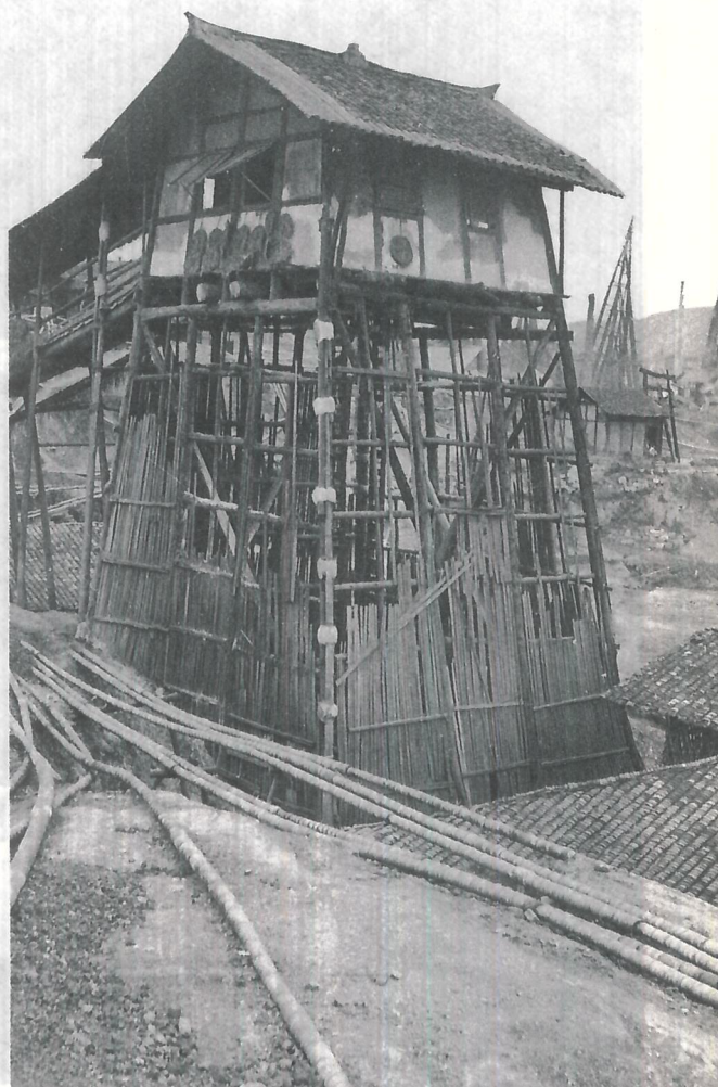
Буровая вышка в провинции Сычуань (фотография 40-летней давности). На переднем плане видны традиционные бамбуковые трубы, по которым природный газ подавался в близлежащие города.
